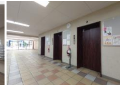
エレベーター
